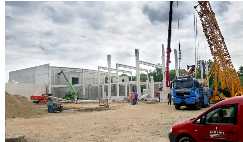
Rohbau Anfang Juni
